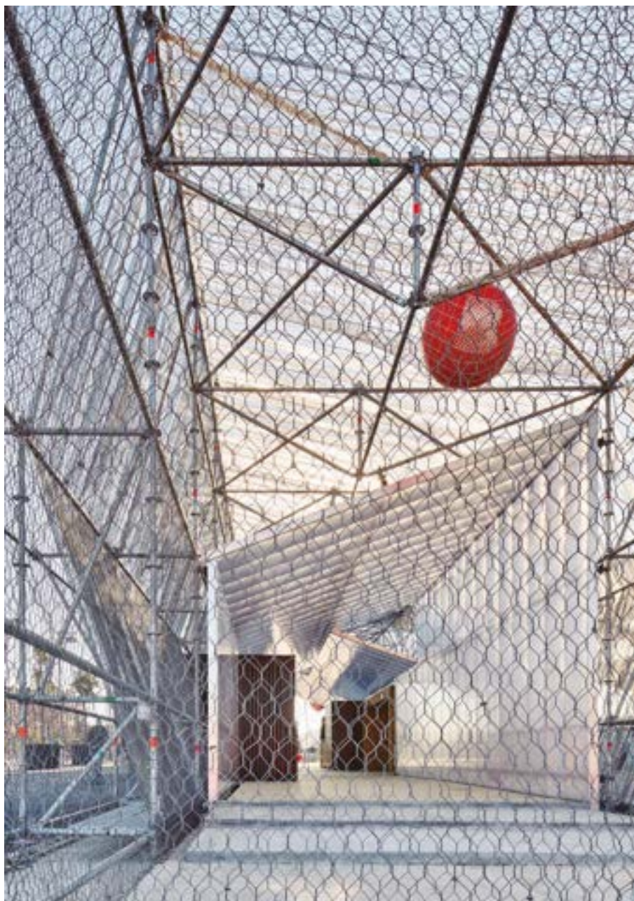
Punto de información – Urbanización provisional Glòries, Barcelona
