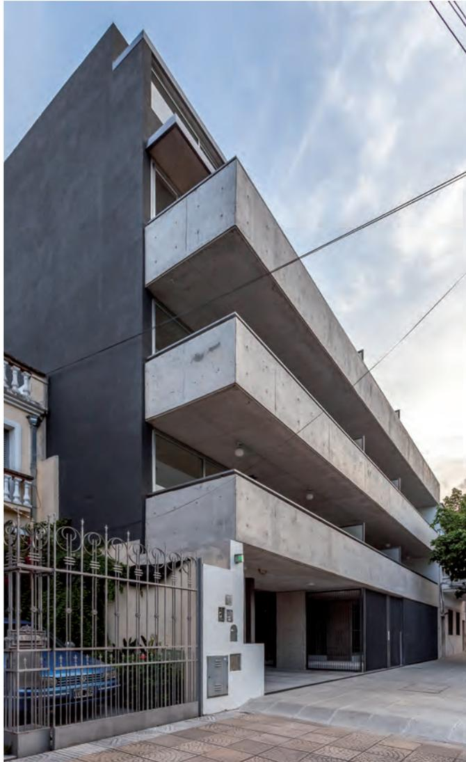
idea de la estructura como lenguaje: el hormigón estructural queda visto, sin pintar, apelando a diferentes tipos de encofrados para que la luz resalte las distintas terminaciones. Grandes paneles vidriados con carpinterías de aluminio de piso a techo, revoque interior de yeso y revoque exterior
